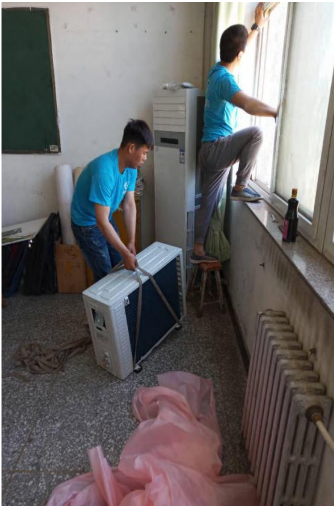
附件 9：项目施工照片
