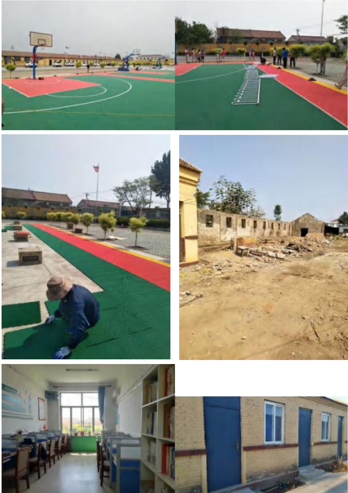
附件 7：工程施工期间照片
