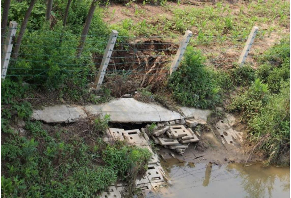
图 3-4 下游段堤防护砌现状
