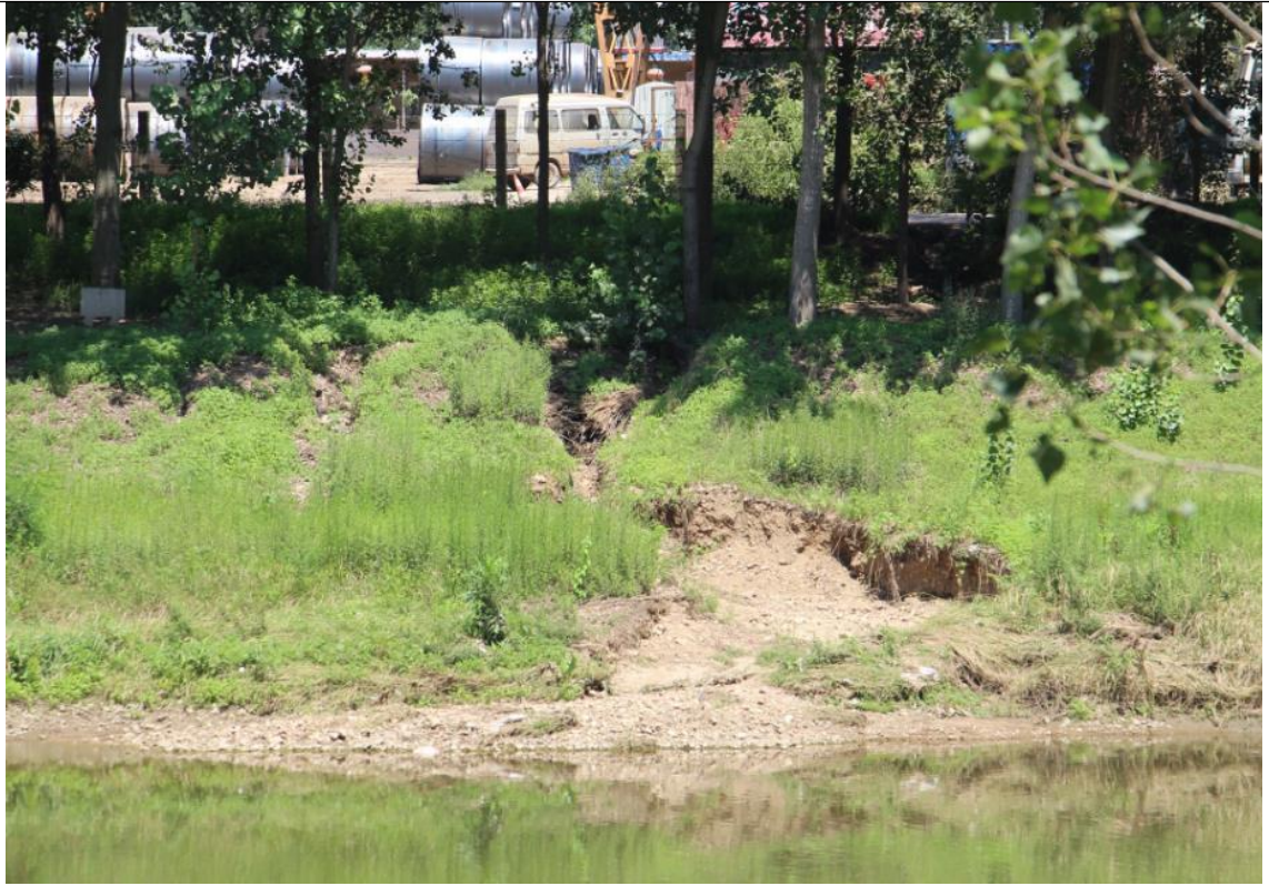
图 3-2 上游段堤防现状
