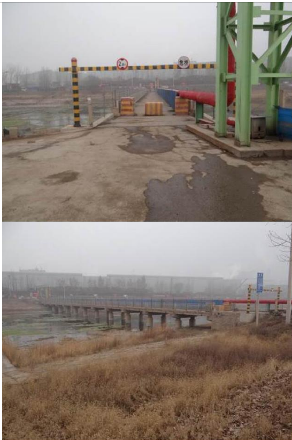
图 3-6 杨家庄桥现状
