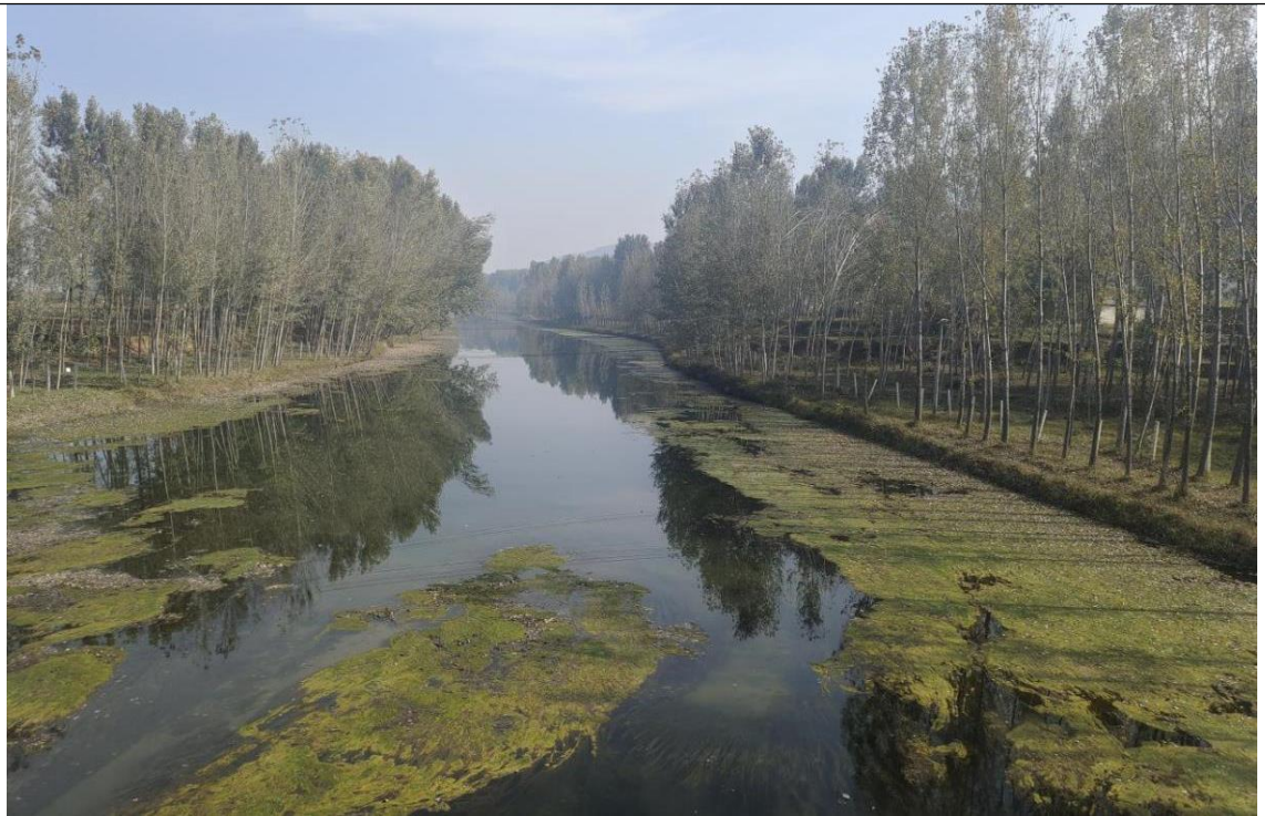
图 3-3 下游段岸坡现状
