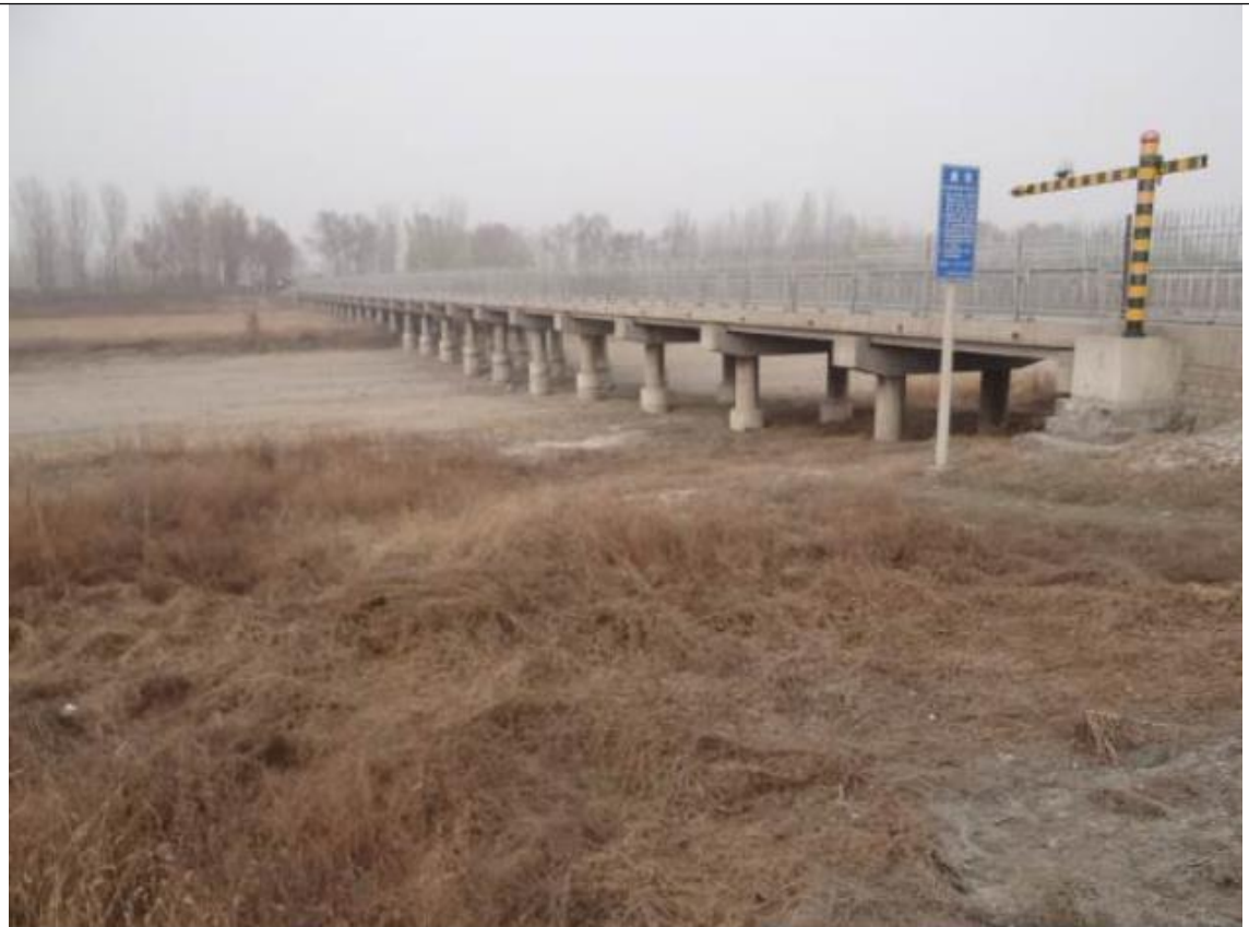
图 3-7 崔家庄 2 号桥现状
