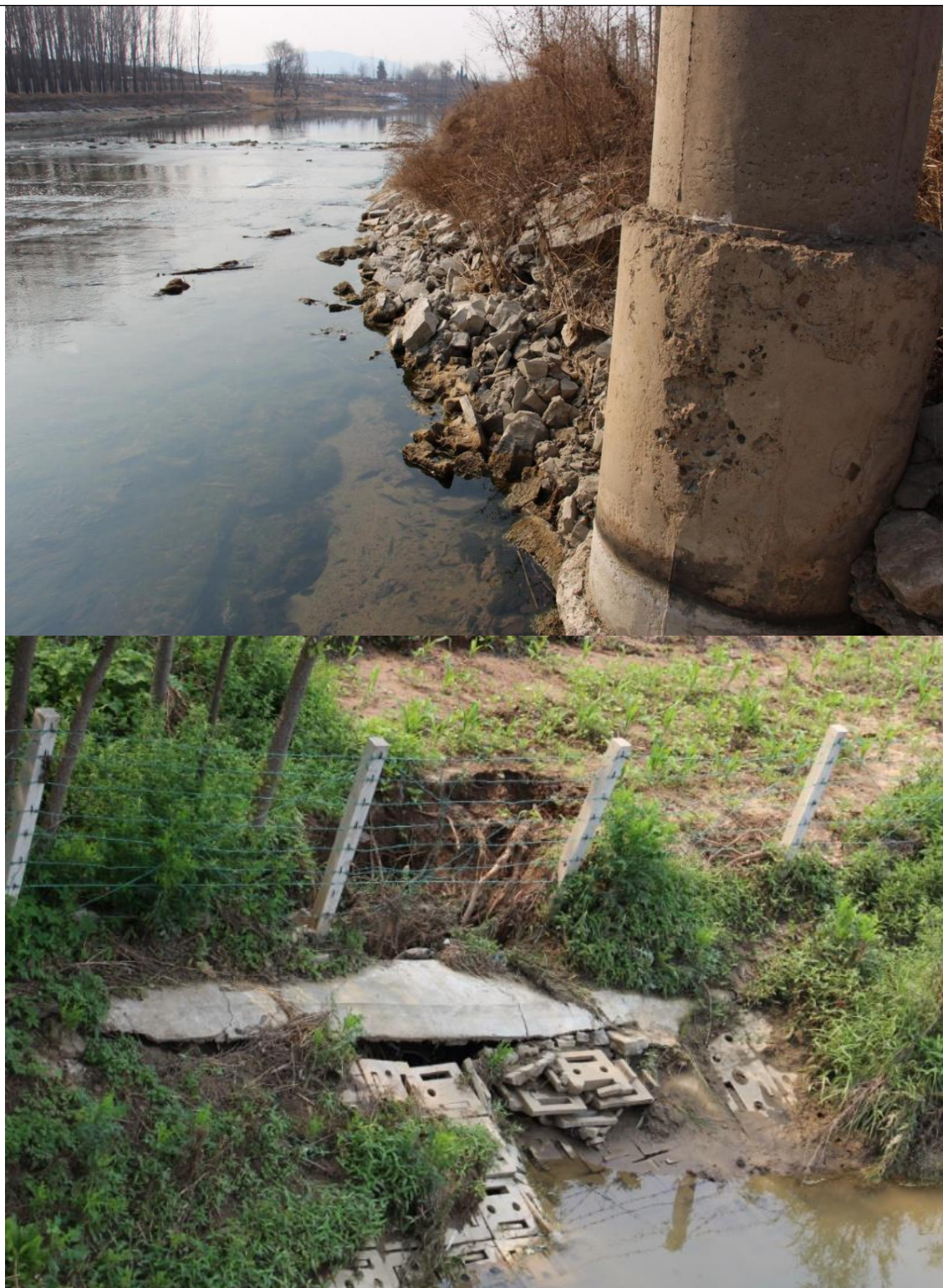
图 3-4 下游段堤防护砌现状
