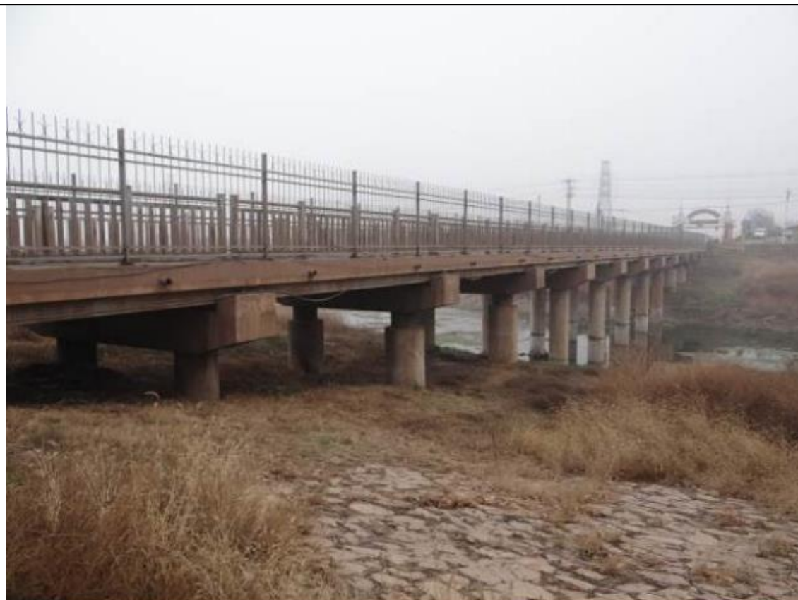
图 3-5 王老庄桥现状
