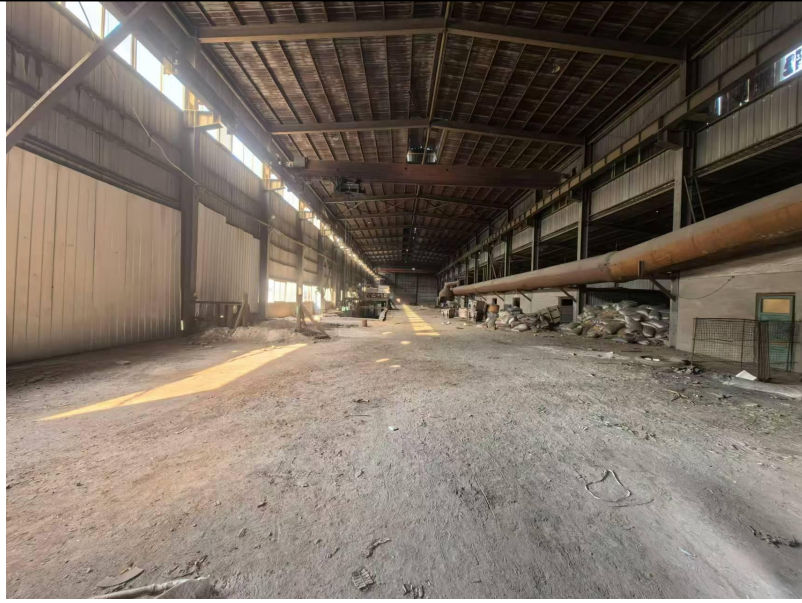
图 2-4 现场勘查照片
