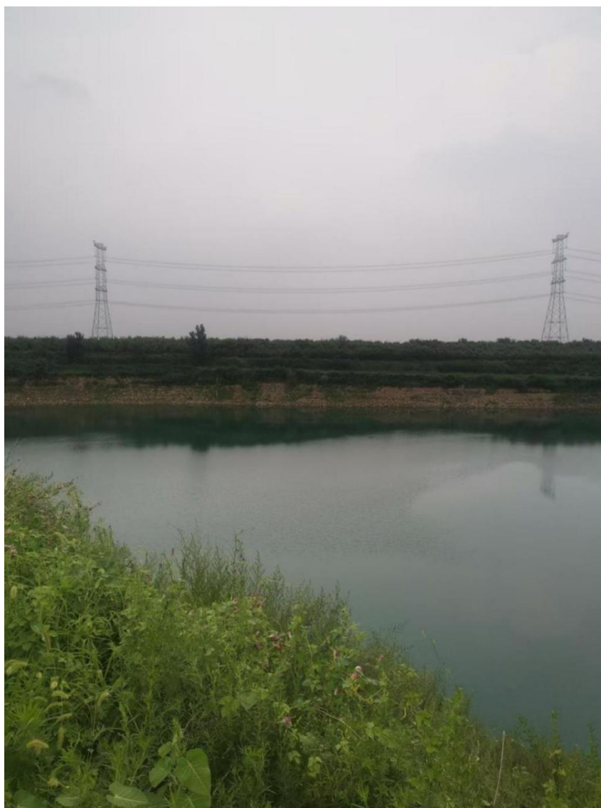
图 3-1 项目堆填场区域现状图
